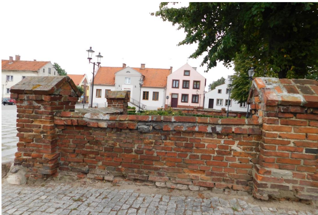
Fot. 1 Stan techniczny przed przystąpieniem do prac odcinek 1-2 oraz od narożnika 2 dwa przęsła
