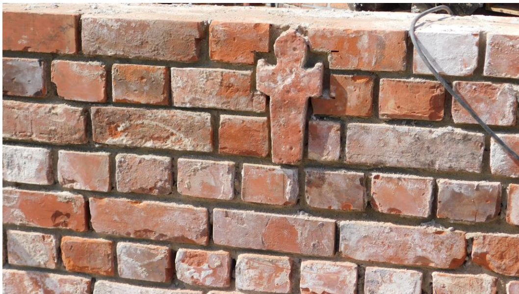
Fot.33 Wbudowanie kształtek ceglanych w mur
