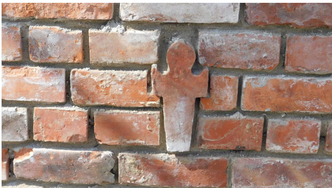
Fot.32 Wbudowanie kształtek ceglanych w mur
