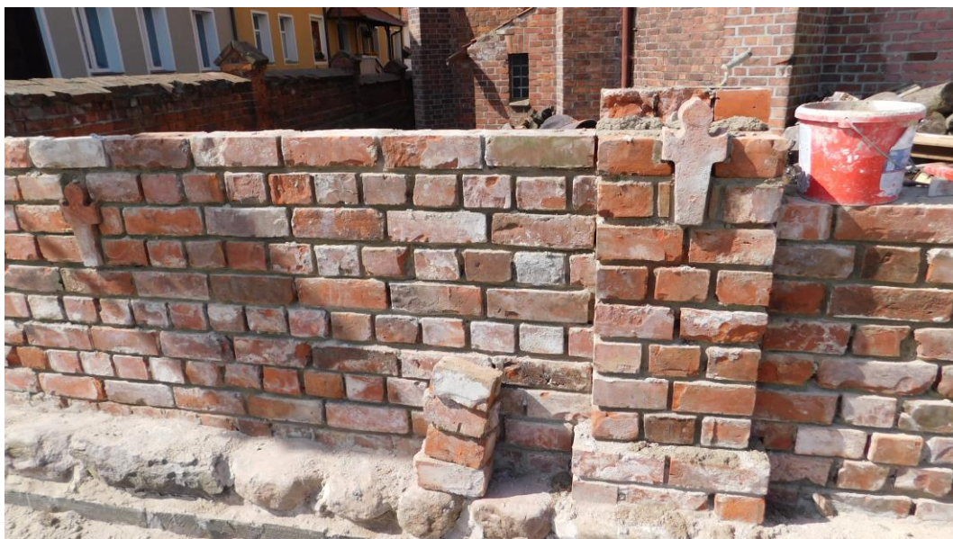
Fot.31 Odbudowa muru ceglanego na fundamentach kamiennych
