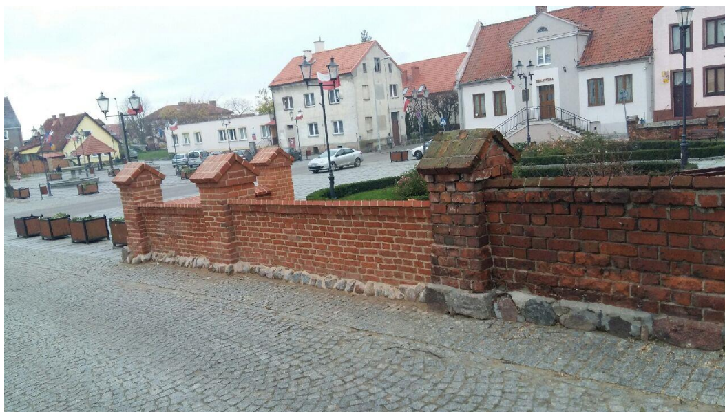
Fot.14 Stan techniczny po wykonaniu prac odcinek 1-2 oraz od narożnika 2 dwa przęsła
