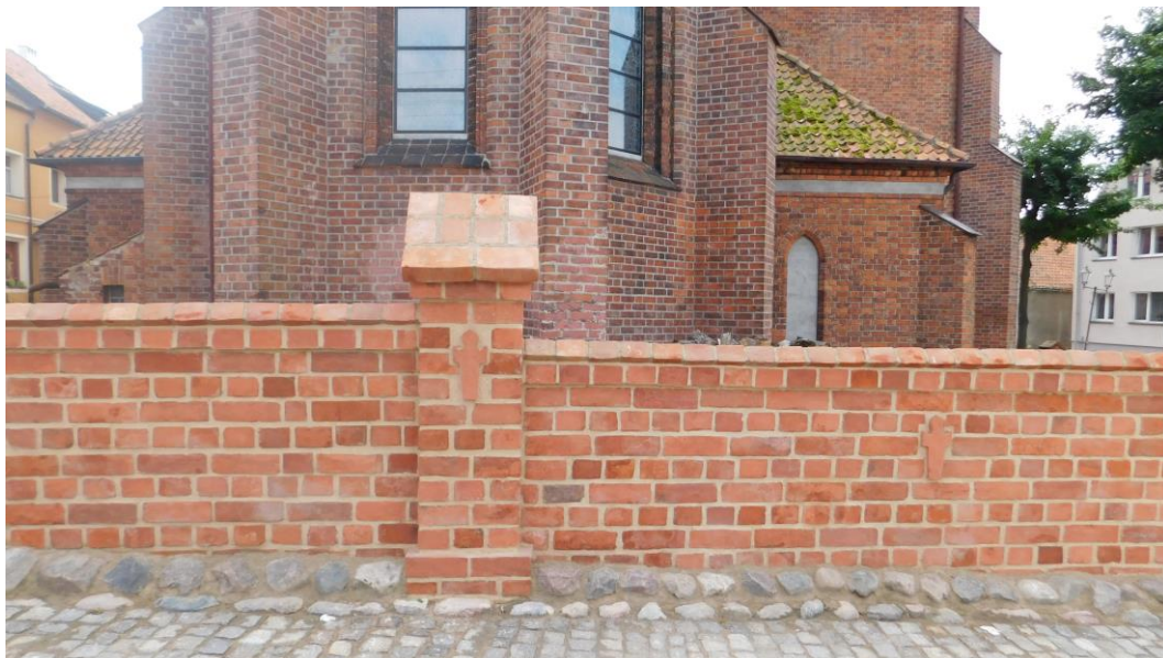
Fot. 39 Stan techniczny po wykonaniu prac odcinek trzech przęseł od narożnika 3 do słupka B1
