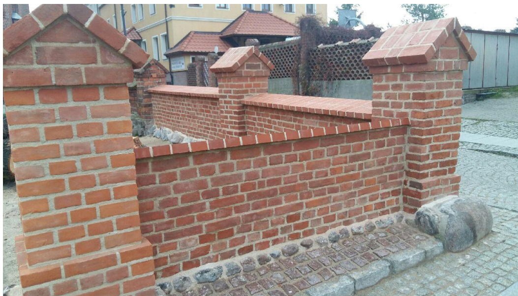
Fot.13 Stan techniczny po wykonaniu prac odcinek 1-2 oraz od narożnika 2 dwa przęsła
