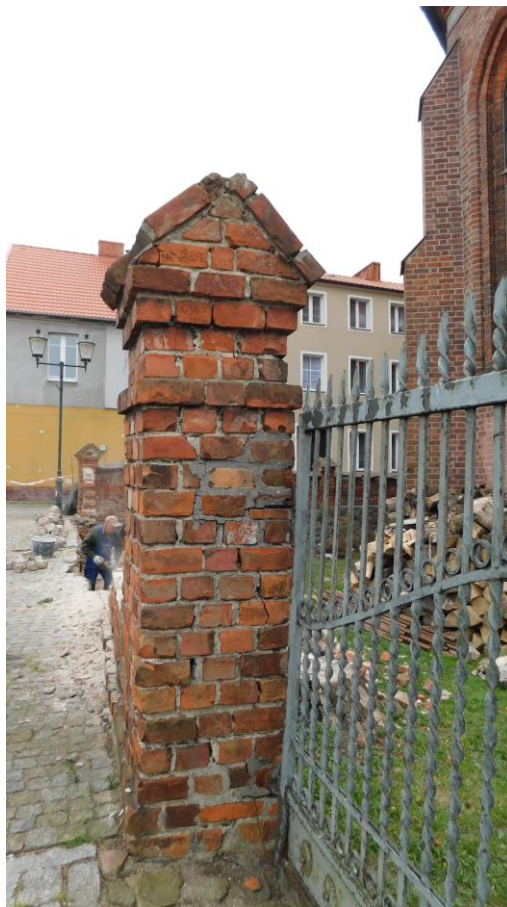
Fot.21 Stan techniczny słupka ogrodzenia
