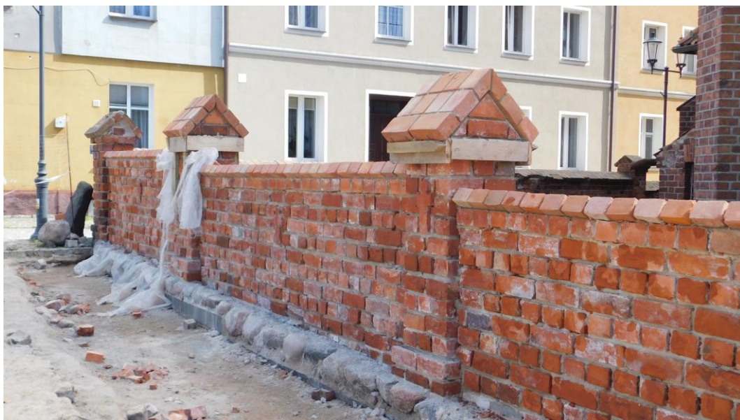
Fot.35 Wykonanie nowych nakryw na murze ceglanym
