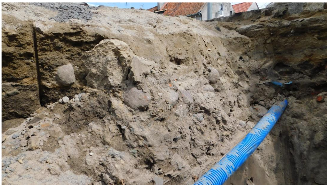
Fot.23 Widoczna historyczna warstwa pierwotnej nawierzchni
