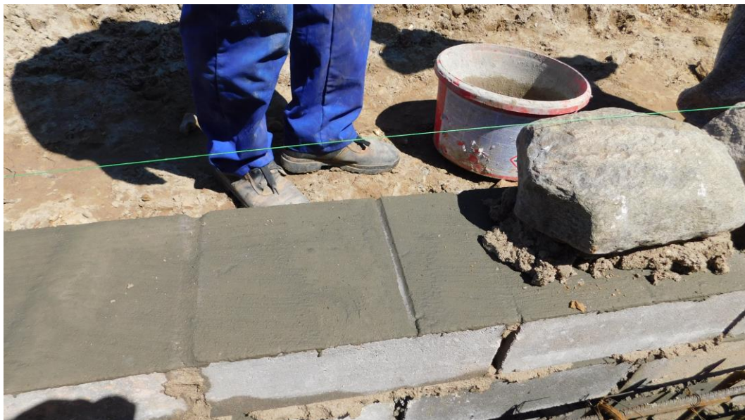
Fot.29 Wykonanie izolacji poziomej pod murem kamiennym
