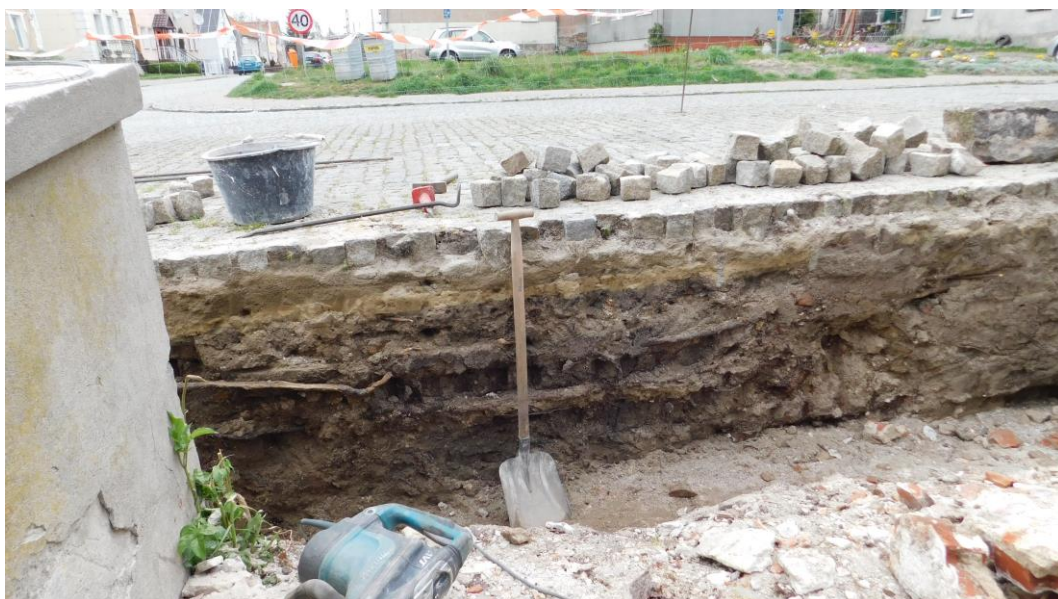
Fot.24 Widoczna historyczna warstwa pierwotnej nawierzchni
