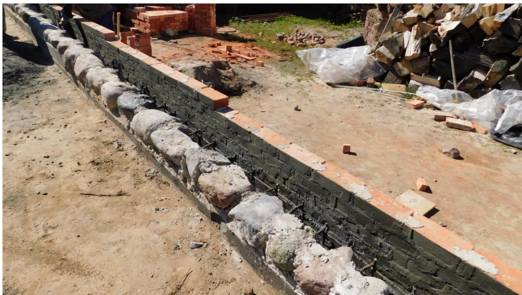
Fot. 30 Wykonanie izolacji pionowej na ścianach muru ceglanego
