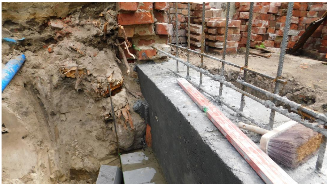
Fot.27 Wykonanie ściany żelbetowej oporowej i z bloczków betonowych
