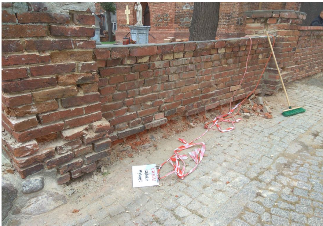
Fot.7 Wykucie skorodowanych cegieł
