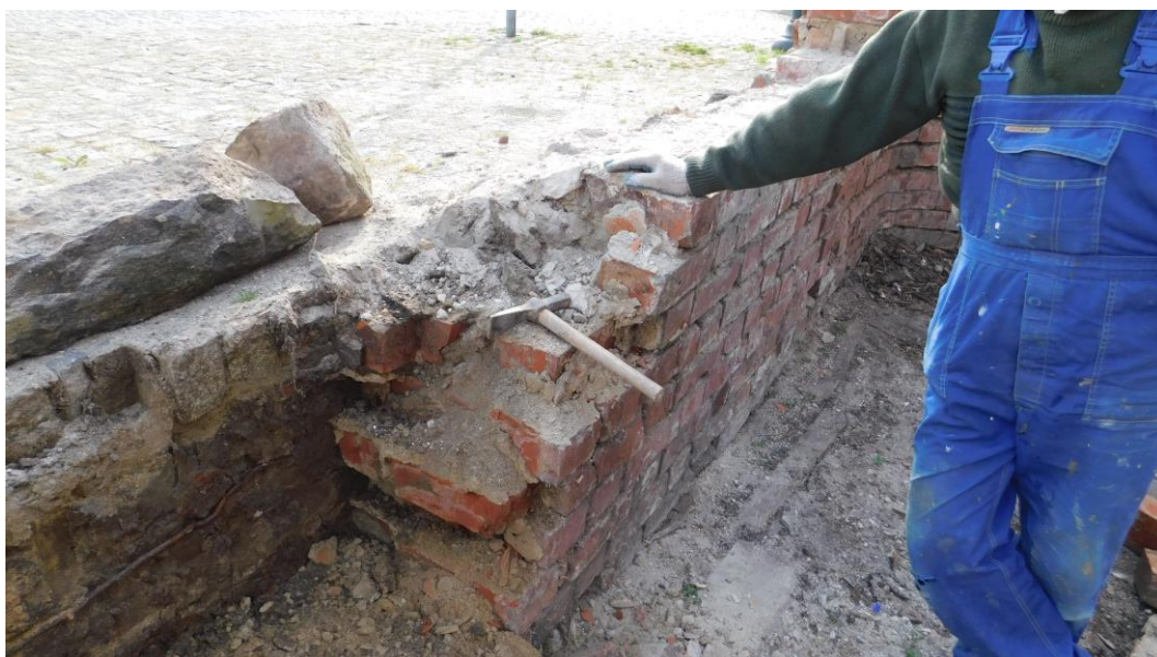
Fot.22 Prace rozbiórkowe
