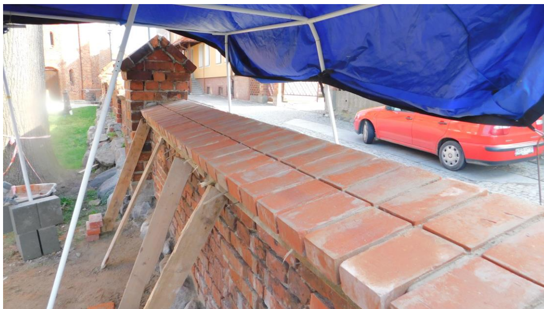
Fot.12 Wykonanie nakryw z cegły maszynowej odcinek 1-2
