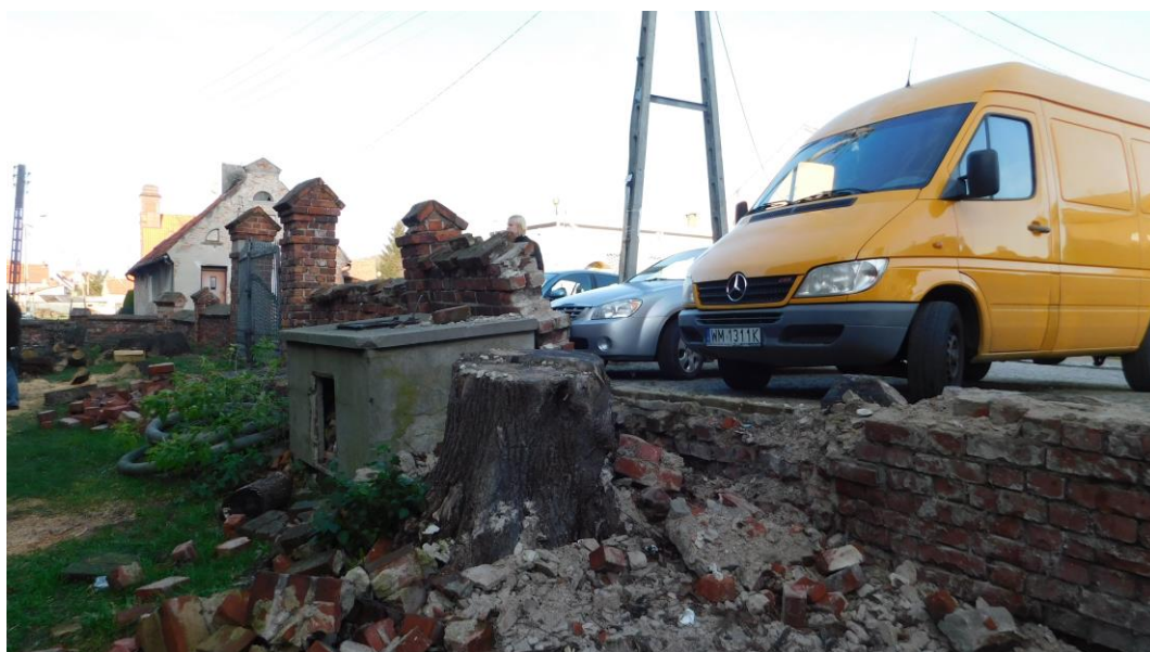
Fot.16 Stan techniczny muru przed rozpoczęciem prac odcinek trzech przęseł od narożnika 3 do słupa B1
