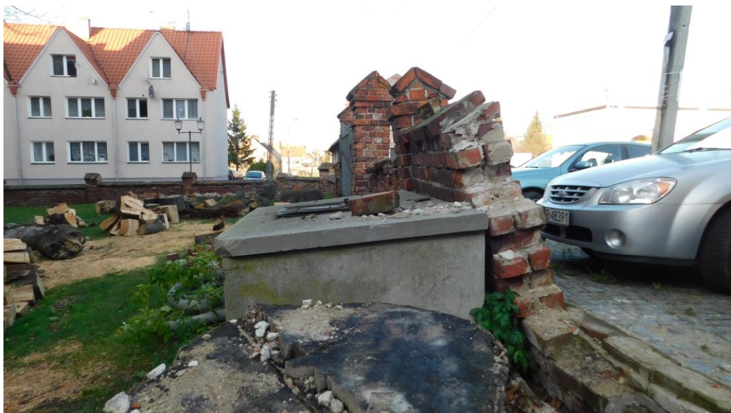
Fot.19 Stan techniczny muru przed rozpoczęciem prac odcinek trzech przęseł od narożnika 3 do słupa B1
