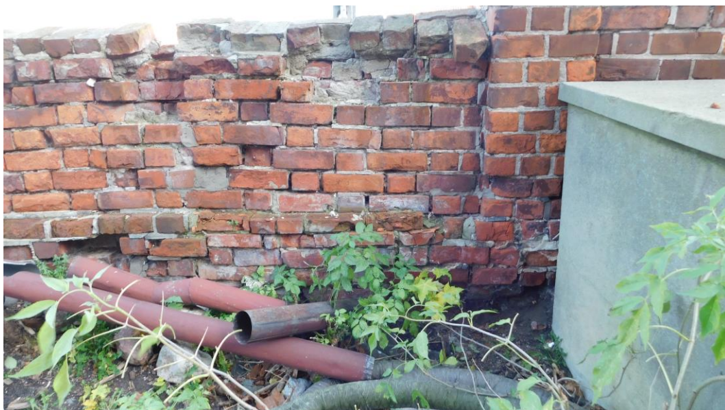
Fot.17 Stan techniczny muru przed rozpoczęciem prac odcinek trzech przęseł od narożnika 3 do słupa B1
