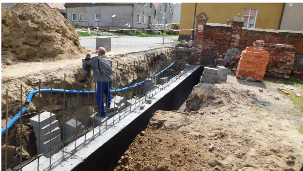
Fot.28 Wykonanie ściany żelbetowej oporowej i z bloczków betonowych
