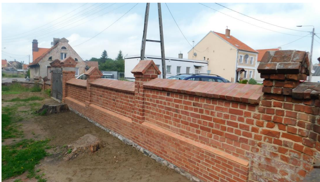
Fot. 38 Stan techniczny po wykonaniu prac odcinek trzech przęseł od narożnika 3 do słupka B1
