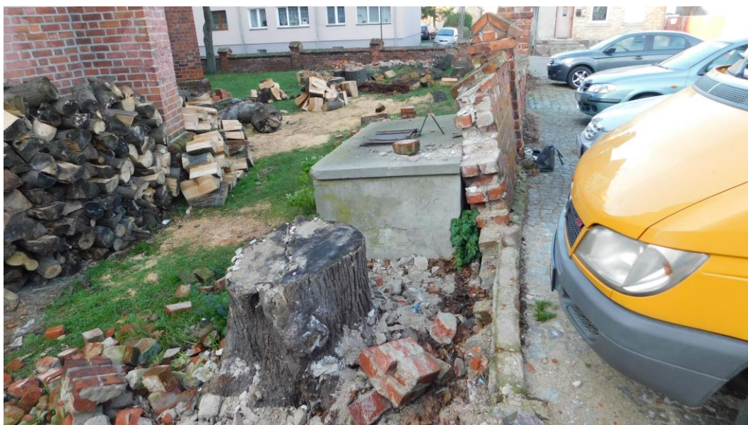
Fot.18 Stan techniczny muru przed rozpoczęciem prac odcinek trzech przęseł od narożnika 3 do słupa B1
