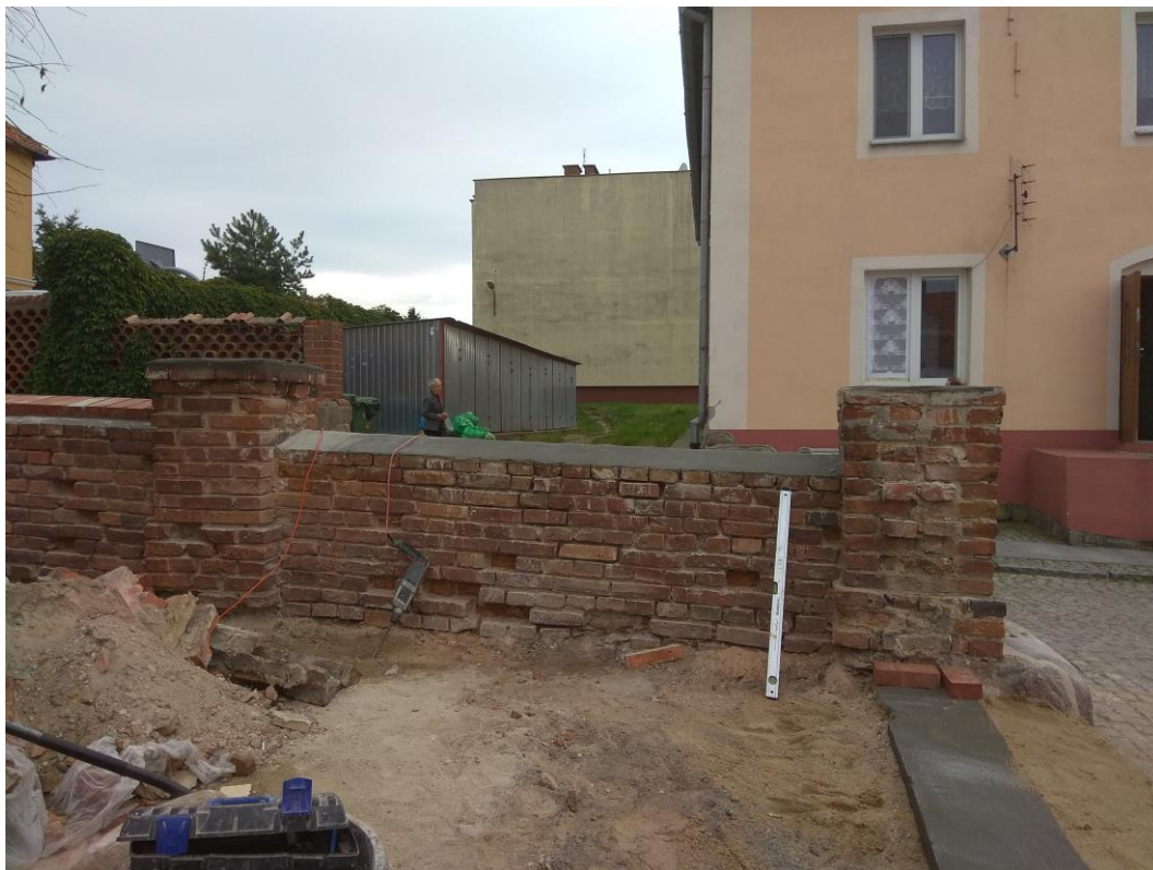
Fot.9 Wykonanie izolacji mineralnej pod nakrywami dwa przęsła od narożnika 2
