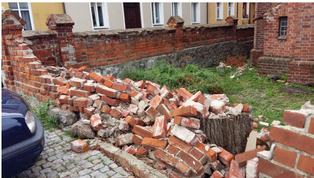
Fot.15 Stan techniczny muru przed rozpoczęciem prac odcinek trzech przęseł od narożnika 3 do słupa B1
