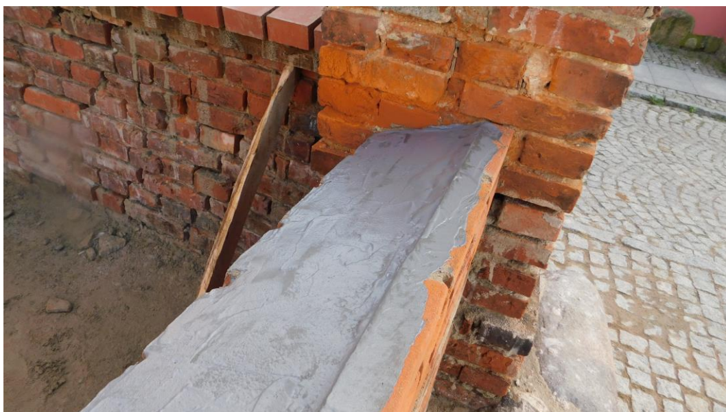
Fot.34 Wykonanie izolacji poziomej mineralnej pod nakrywy
