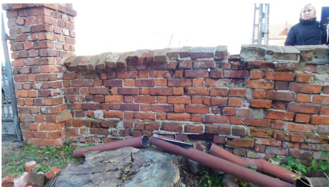
Fot.20 Stan techniczny muru przed rozpoczęciem prac odcinek trzech przęseł od narożnika 3 do słupa B1
